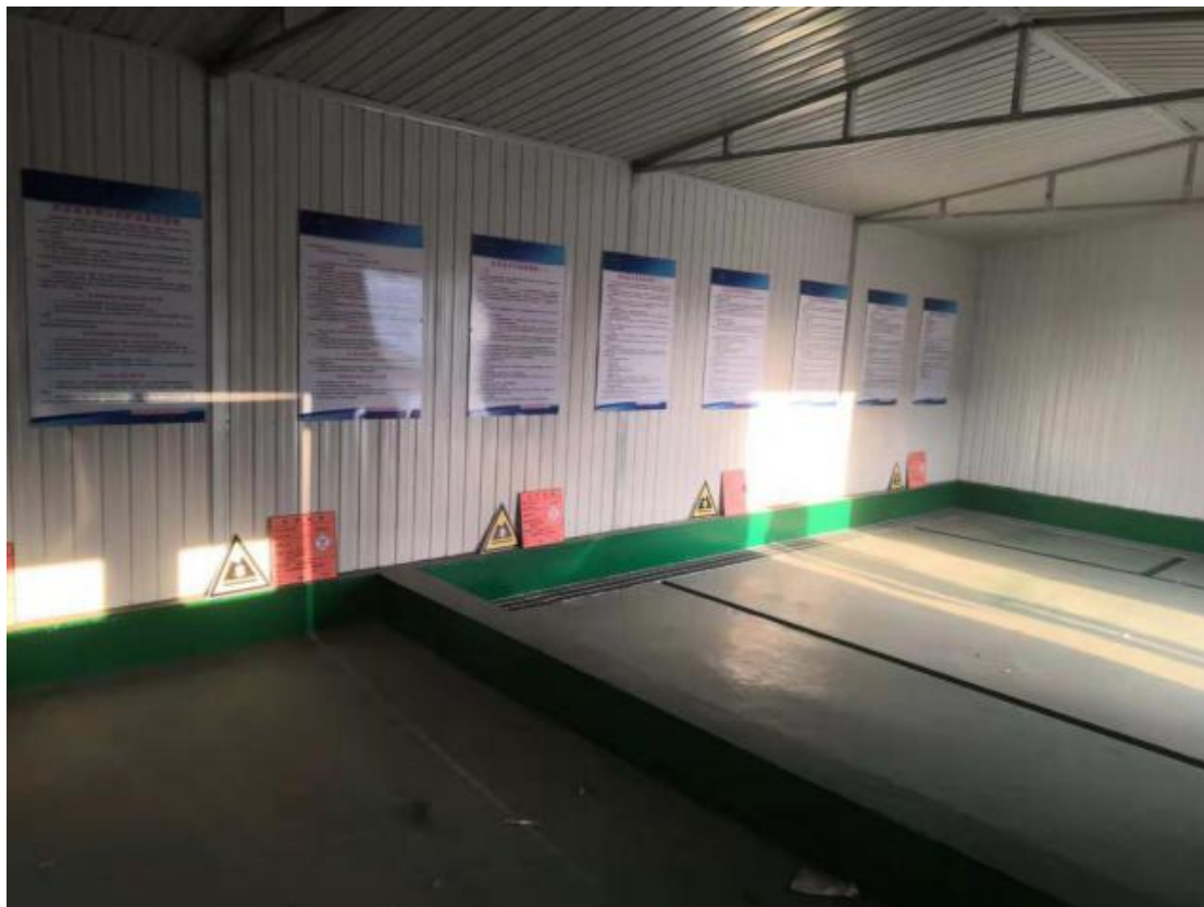
危废间内导流、收集、排气、标识、制度上墙等
