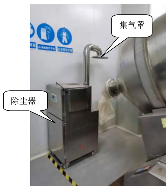
图 4.2-6 集气罩和布袋除尘器
