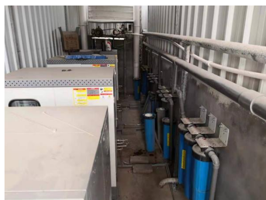
料棚水喷淋抑尘装置照片
