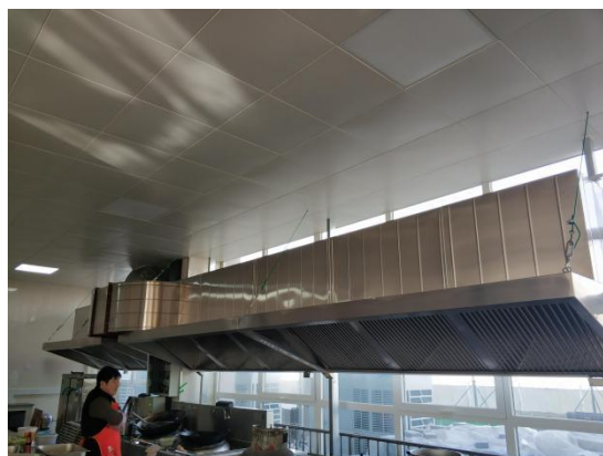
集气罩+油烟净化器照片
