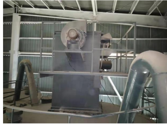
混凝土每 5 组筒仓设置 1 个布袋除尘器照片
