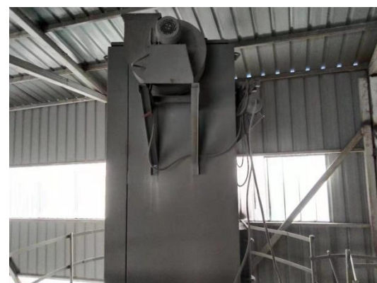
水稳水泥筒仓 2 个布袋除尘器照片
