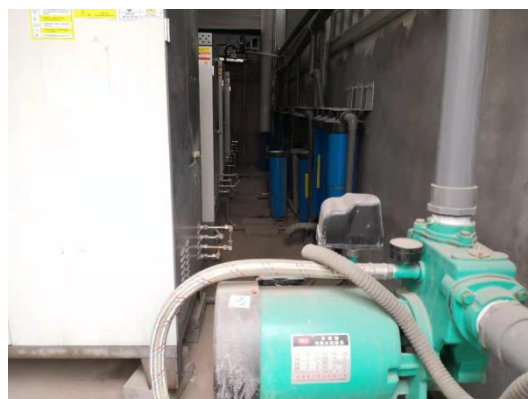
料棚水喷淋抑尘装置照片
