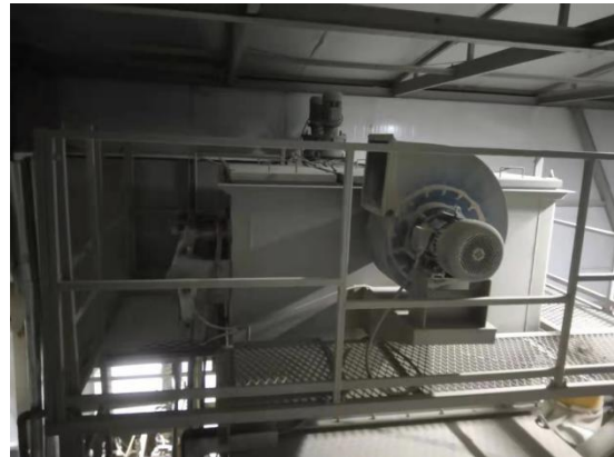
混凝土搅拌废气 2 个布袋除尘照片
