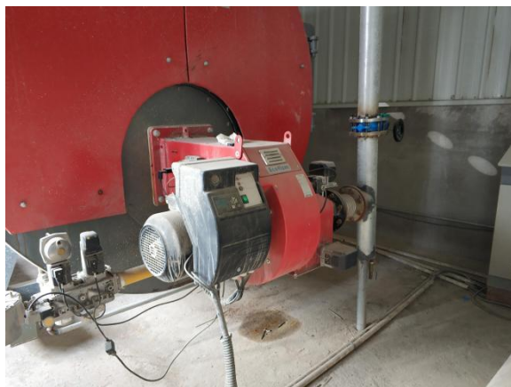
锅炉低氮燃烧器+排气筒照片
