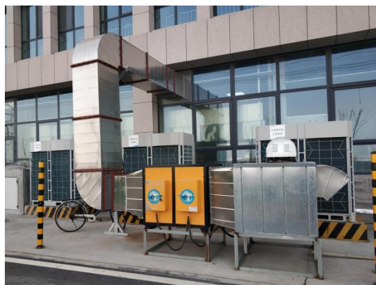
集气罩+油烟净化器照片
