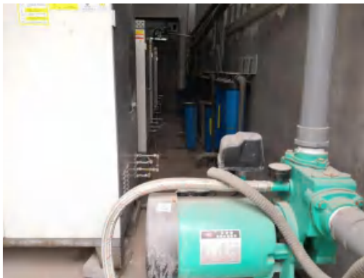
料棚水喷淋抑尘装置照片
