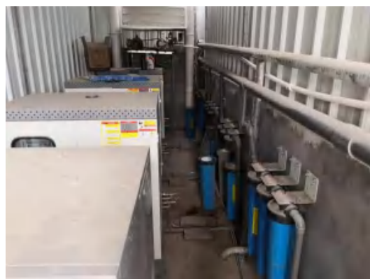
料棚水喷淋抑尘装置照片
