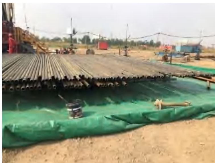
图 6-2 钻井过程中防渗情况
